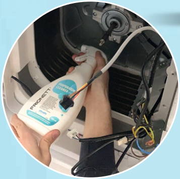
SCHOONMAKEN VAN DE EXTERNE CONDENSOR met Frionett® Condenser Cleaner
